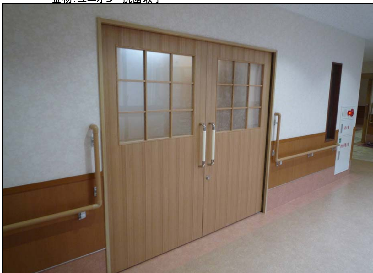
引き分け吊りフラッシュ戸 (SD枠) 面材:タモ突板 金物:ユニオン 抗菌取手
