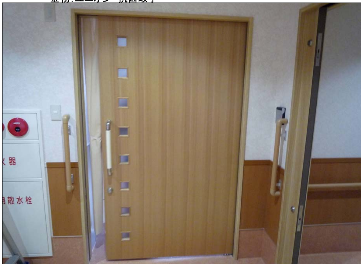
引き分け吊りフラッシュ戸 (SD枠) 面材:タモ突板 金物:ユニオン 抗菌取手
